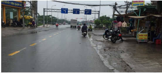
Hình 4. Hiện trạng lề đường và nắp hố ga thoát nước
